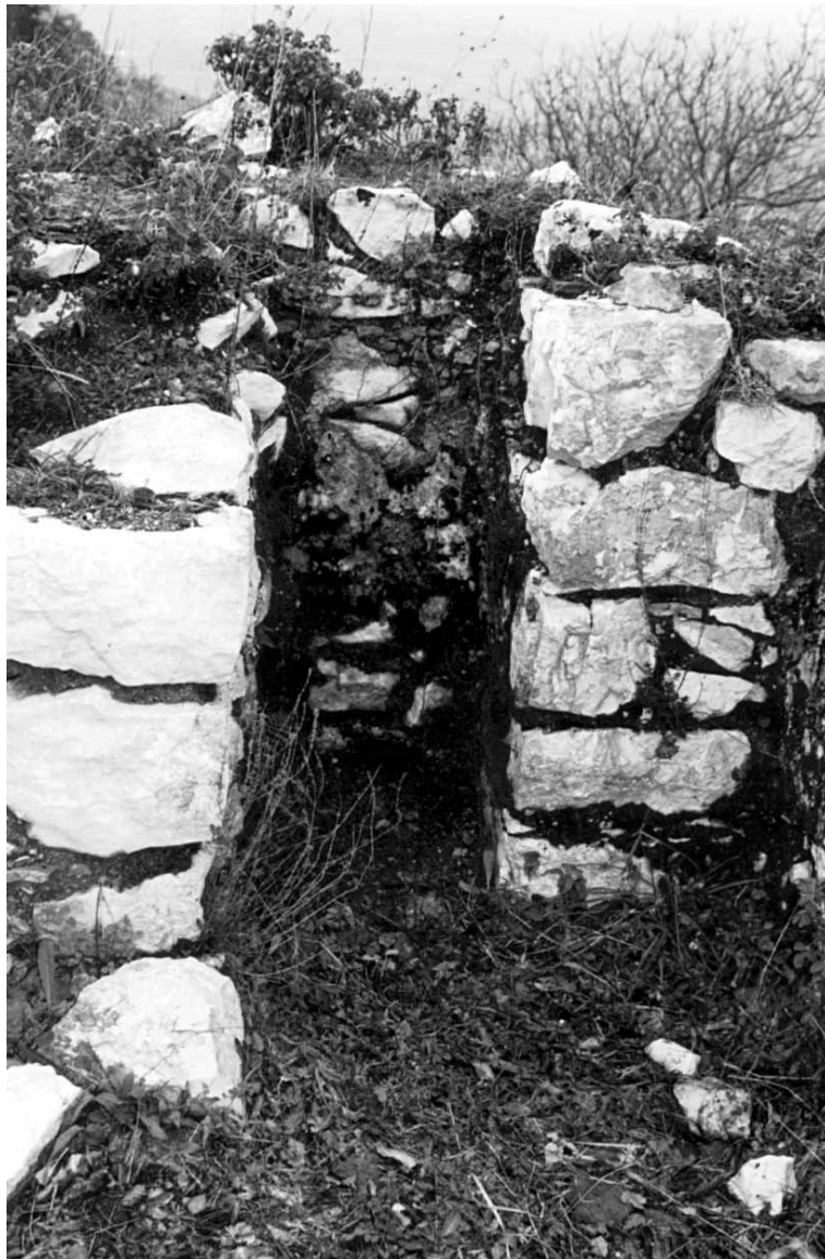
9. Il vano più settentrionale con i due frammenti murari adiacenti
